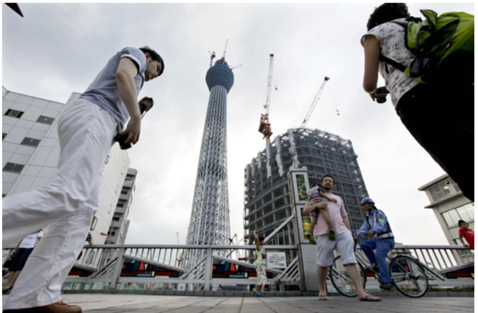
Bij de televisiemast Tokyo Sky Tree worden in Tokio nieuwe appartementen gebouwd voor €375.000 per stuk.
